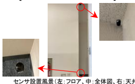
センサ設置風景(左:フロア、中:全体図、右:天井)
